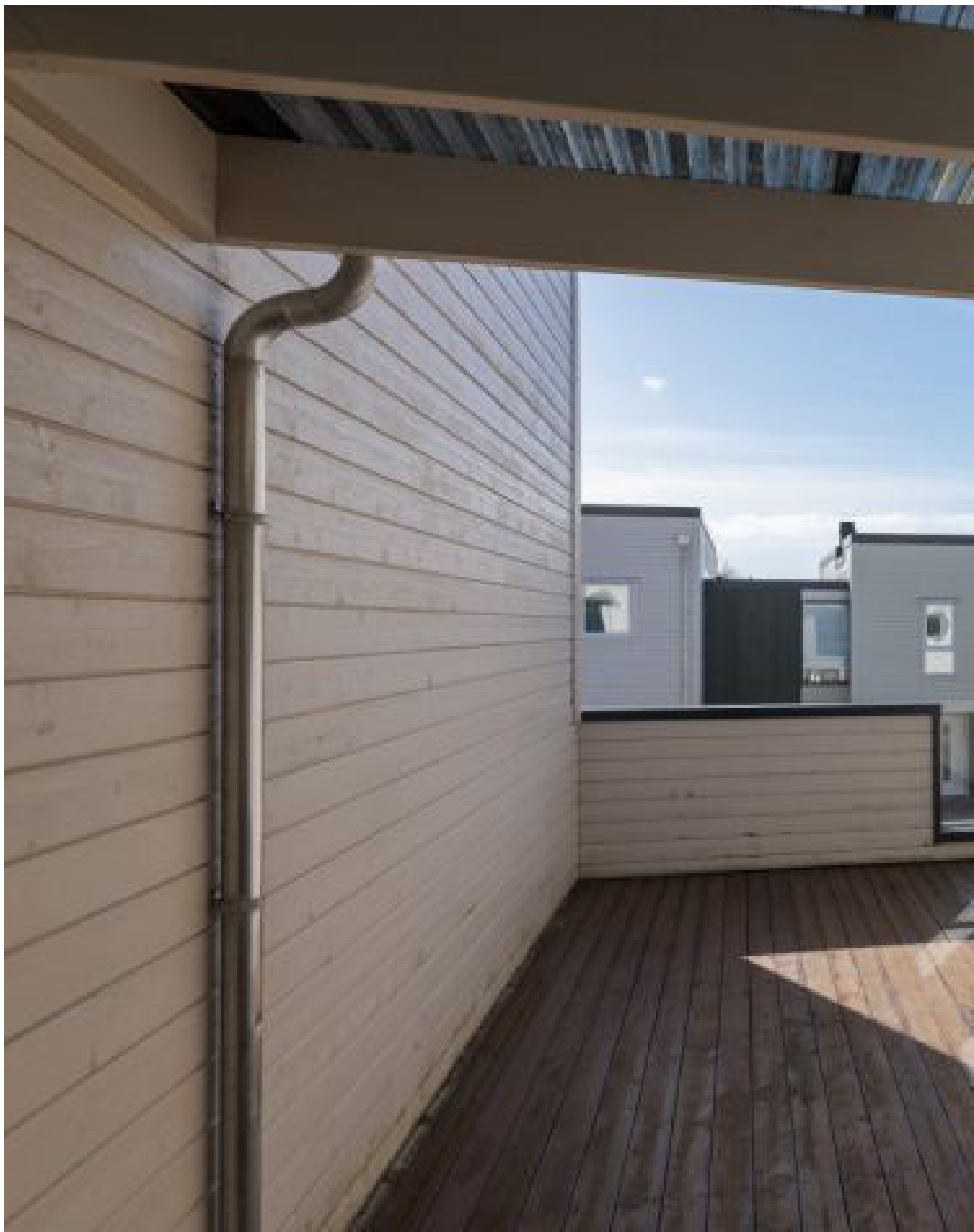
Vestvendt og delvis overbygget takterrasse.
