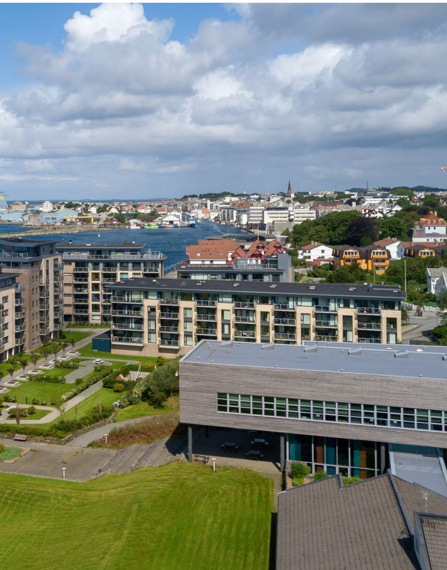
Pent opparbeidet fellesareal
