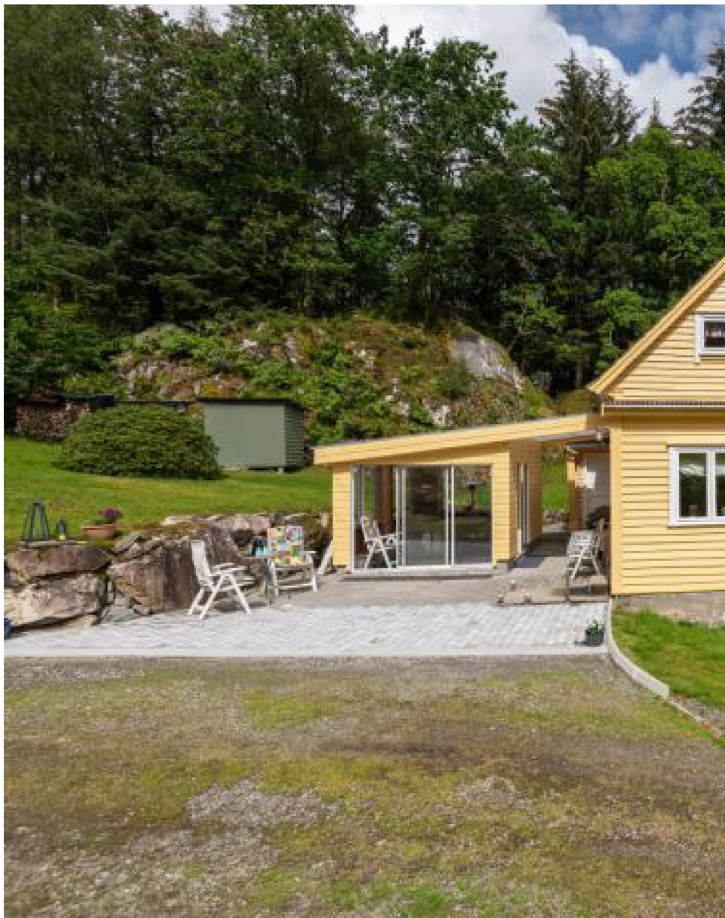
Inngangspartiet er opparbeidet med belegningsstein og gir et godt førsteinntrykk. Hagestuen ble oppført i 2017.
