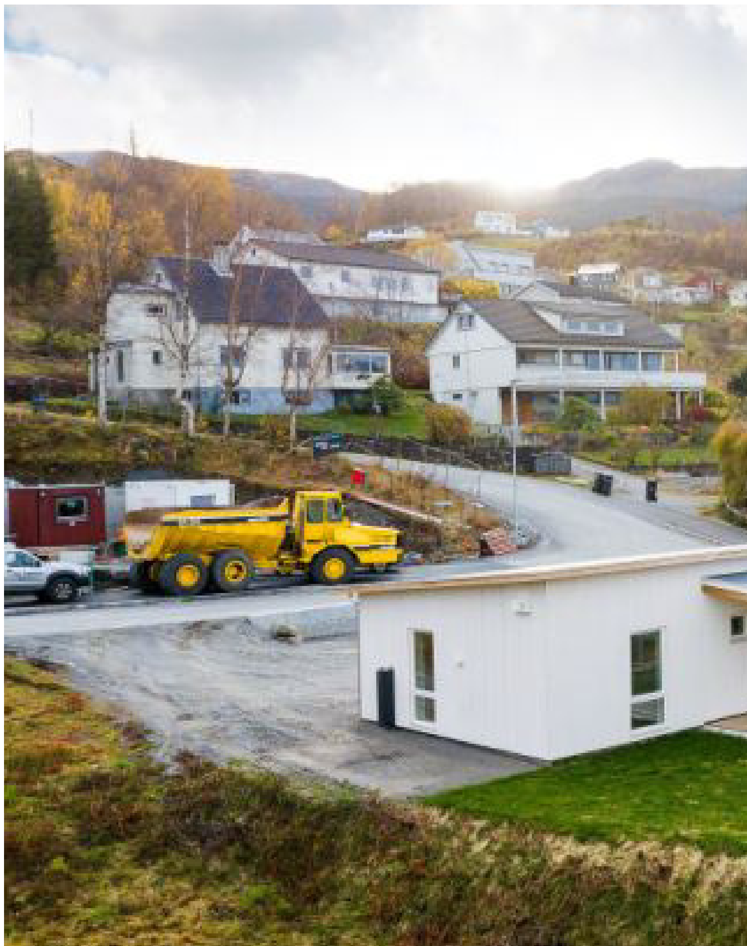
Tomta er opparbeidet med plen, markterrasse og grus i gårdsrom.
