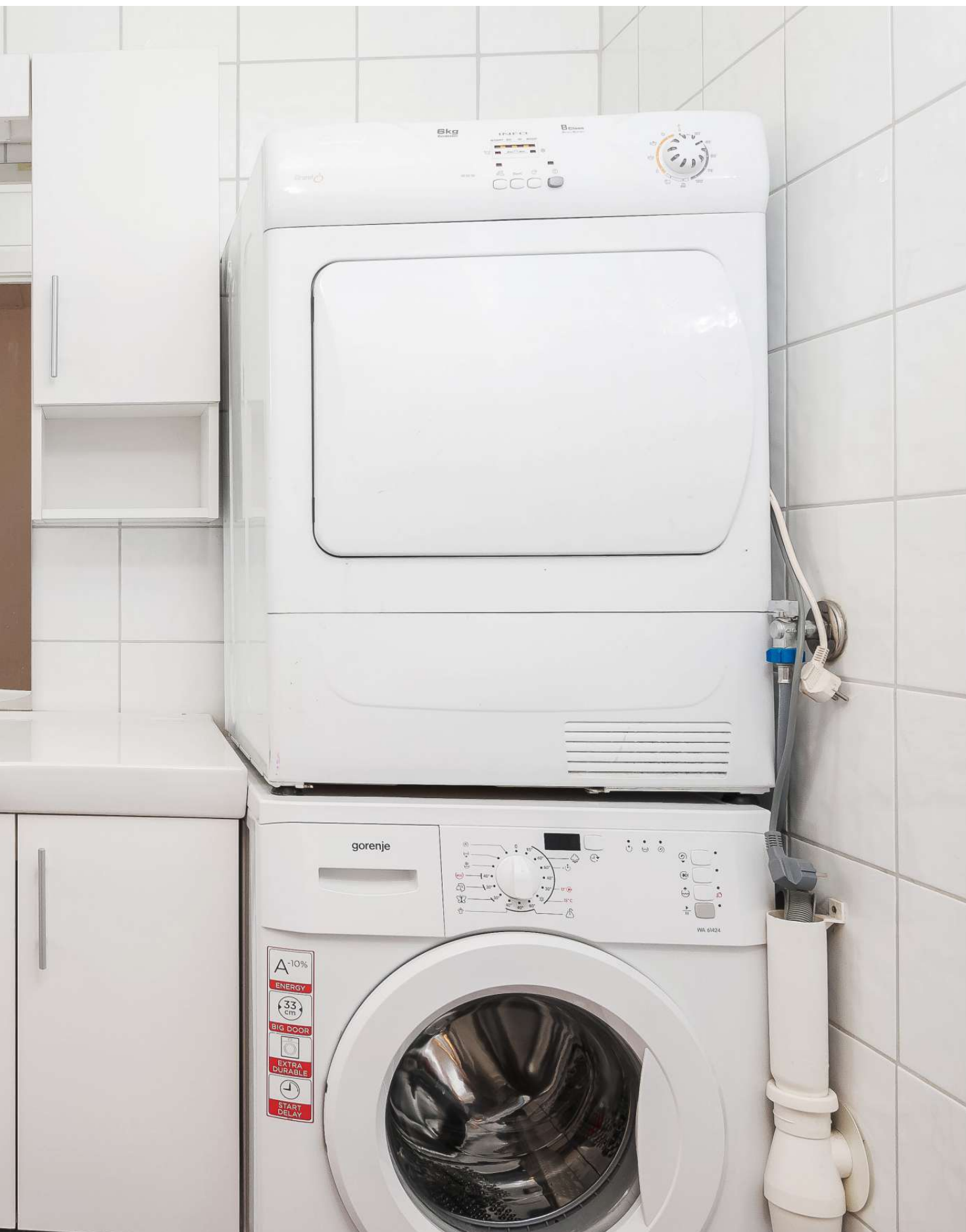
Helfliset bad som inneholder vegghengt wc, opplegg for vaskemaskin og baderomsinnredning med helstøpt servant og overhengende speil med belysning. Varmekabler i gulv.
