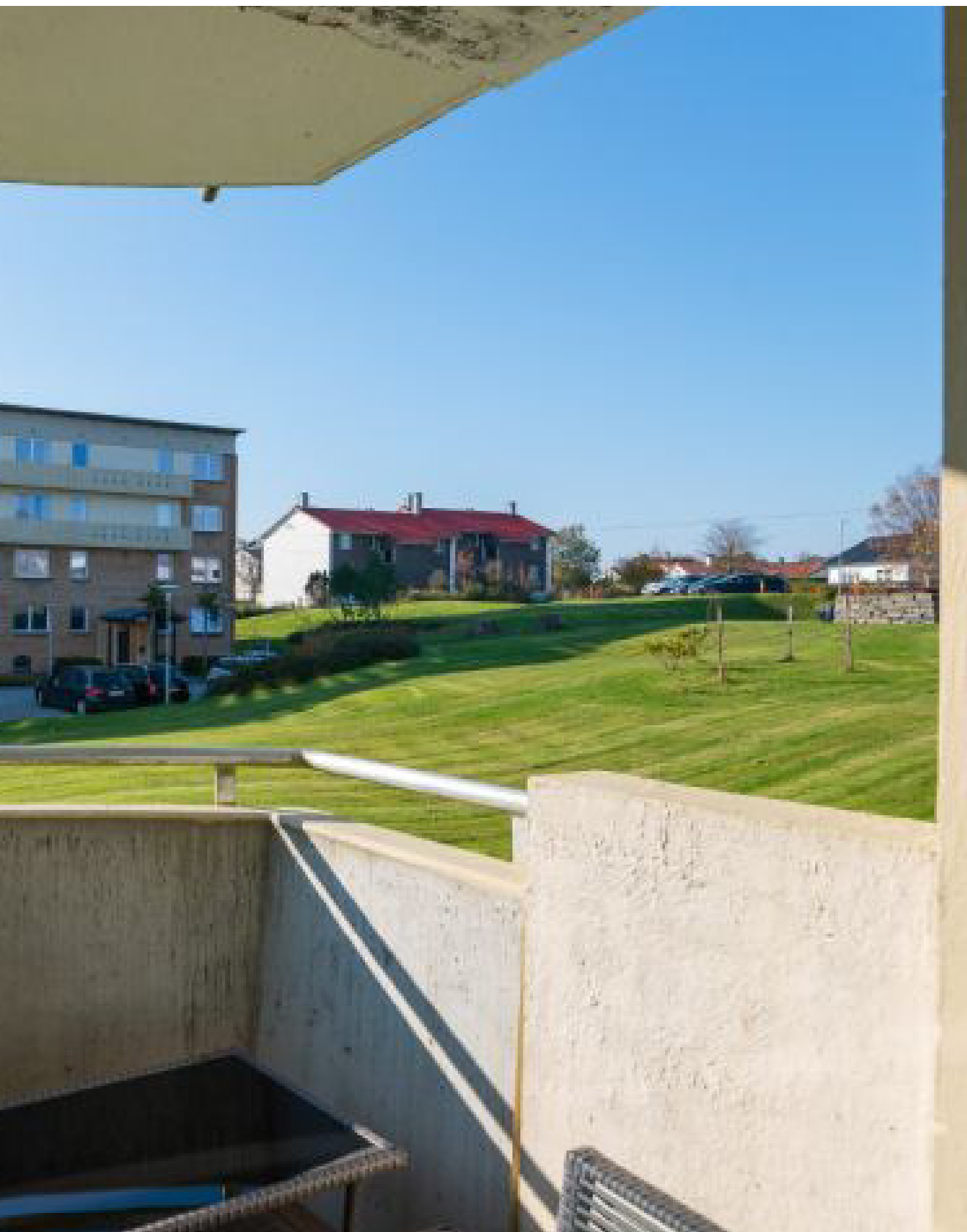
Altan med utsyn mot fellesarealene
