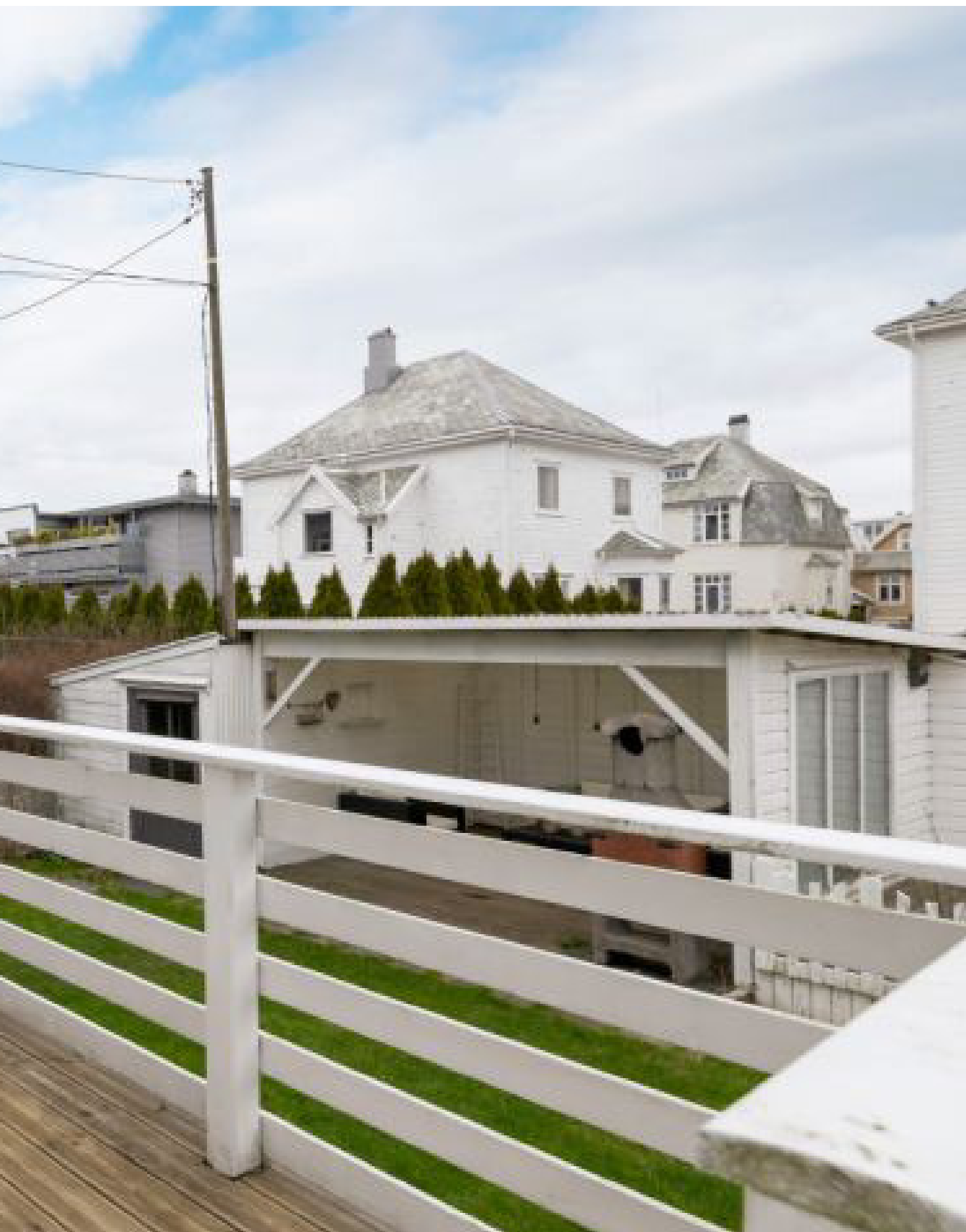
Altan med utgang fra stuen i 1. etasje.
